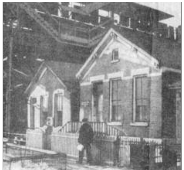
Huizen bij het metrostation Paulina op 14th Place, Groninger Hoek, Chicago 1941. Deze buurt stond onder de inwoners bekend als de 'Klompboulevard'. De bruggetjes voor de huizen leidden naar de voordeur op de tweede etage, en waren gebouwd wegens het door de modderoverlast verhoogde straatniveau. 4
