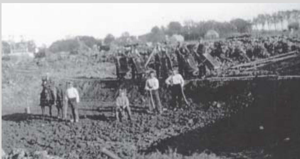
Het egaliseren, enz. van het plan van uitbreiding gebeurde met de schop. De foto is genomen in zuidelijke richting. De bomen midden op de achtergrond omhullen het gemeentehuis en het huis ernaast op de hoek van de Schillegemsterweg.
