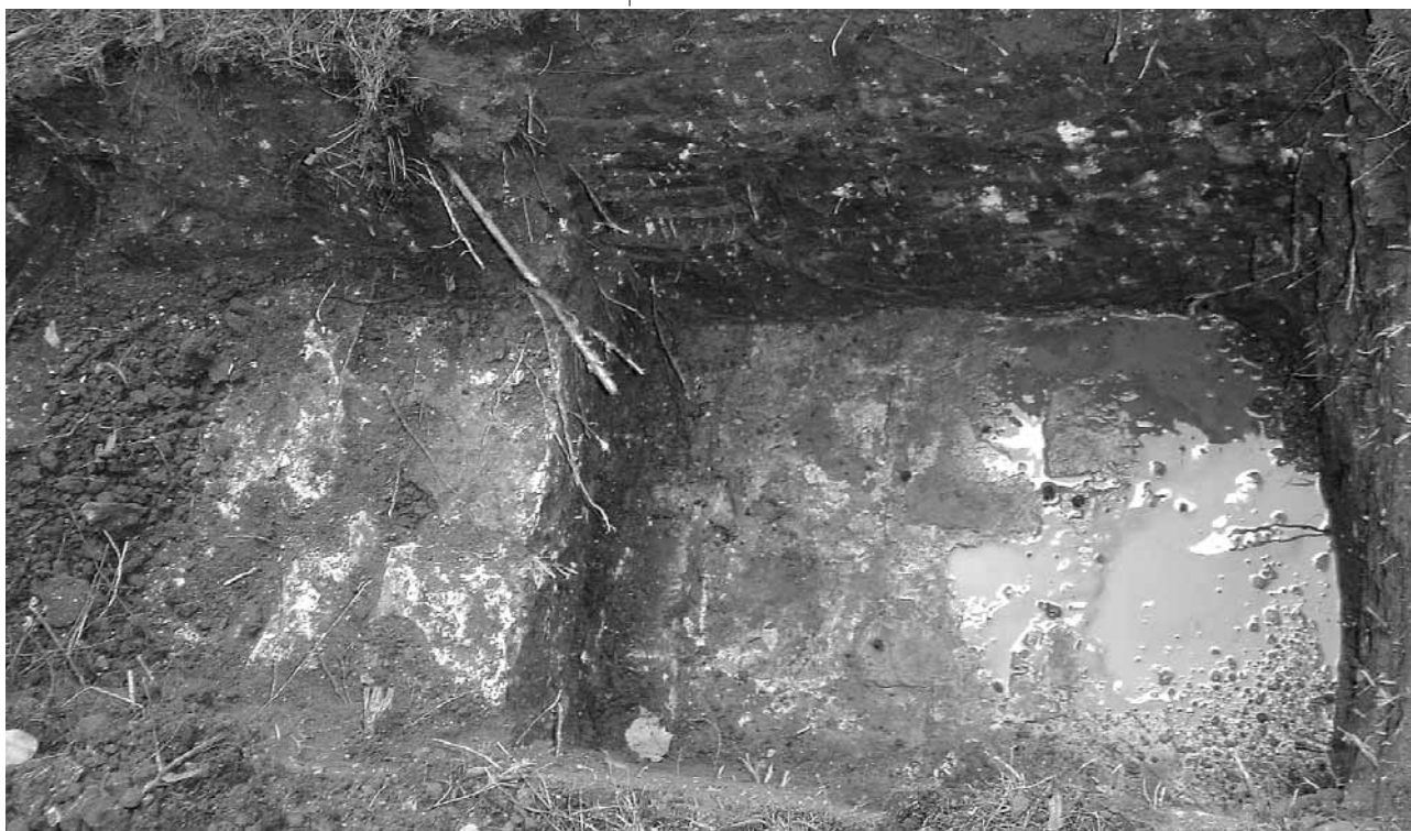
Foto 10. Een deel van de aangeprikte muurfundering.
