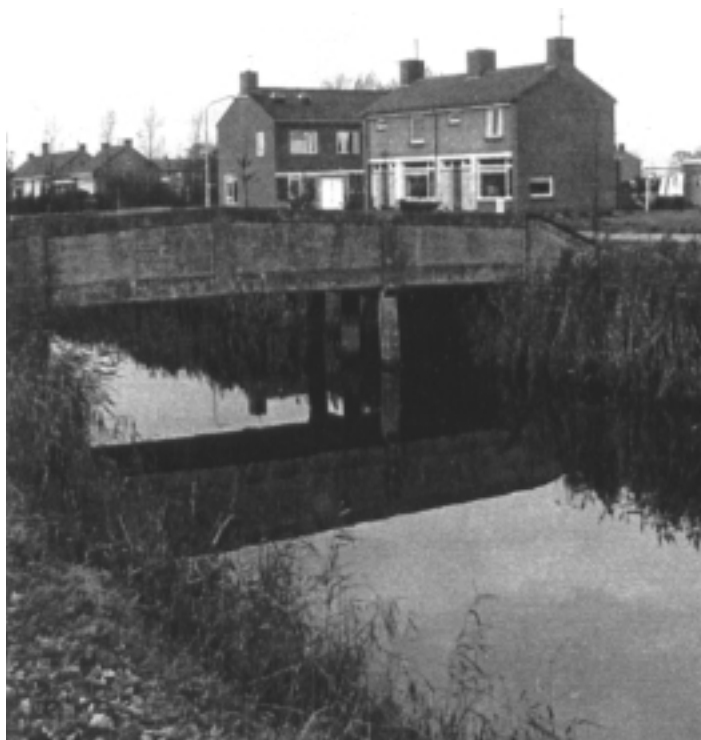
De oostelijke betonbrug over het omsnijdingskanaal. De brug werd "Pastorietil" genoemd. Geheel links de Mavo-school. (Foto: P. Noord, juli 1966).
