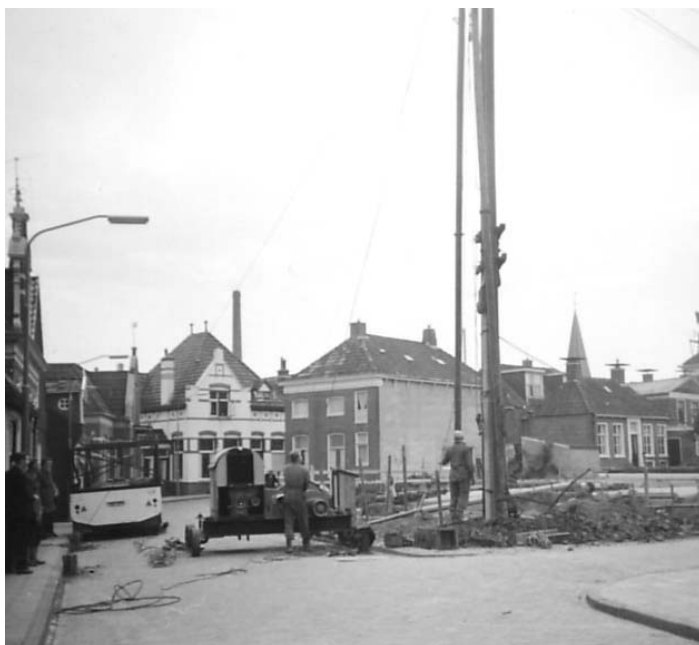
Heiwerkzaamheden tijdens de nieuwbouw in 1961.
