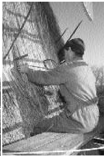
November 1994, de rietdekker aan het werk.
