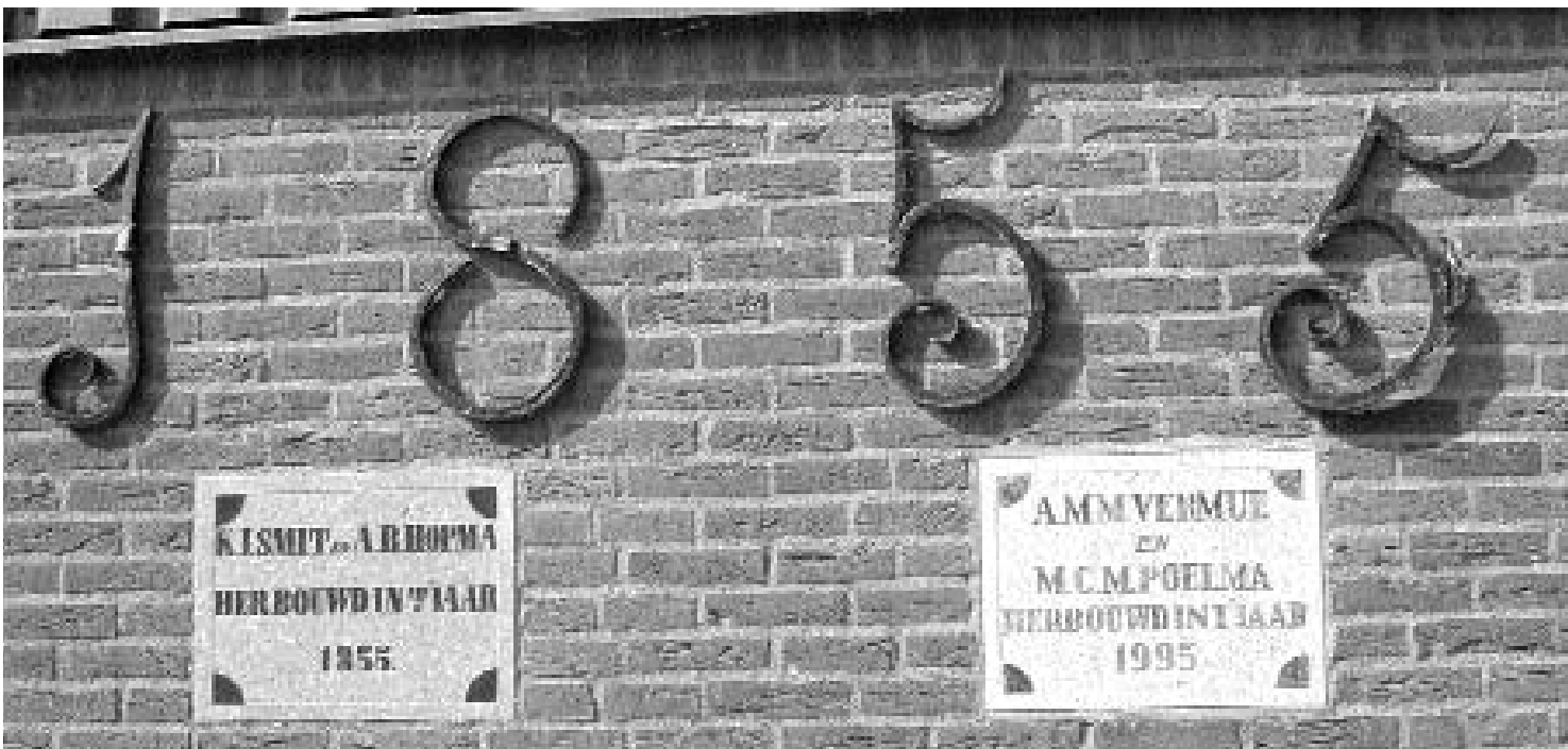
Afbeelding 3. Muurankers en steen van de herbouw van Tijum in 1855 en de steen van de herbouw in 1993-1995 in de zuidmuur van de schuur. (foto: J. Tersteeg).
