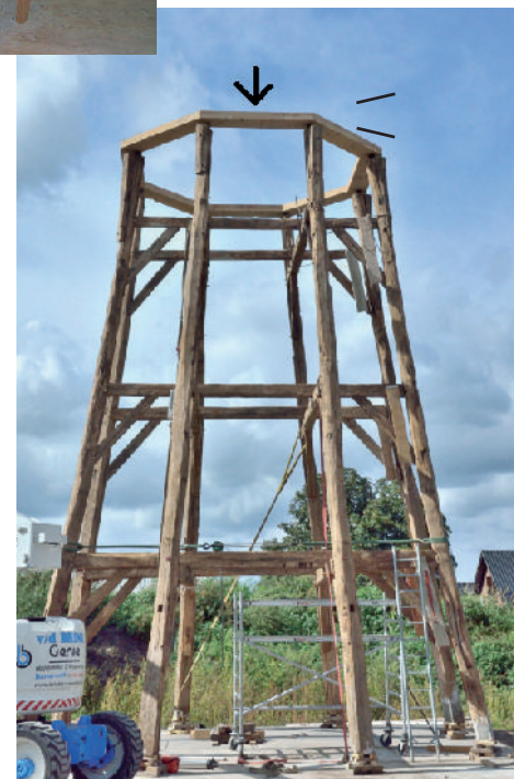
Achtkant met bintlagen en boventafelement
