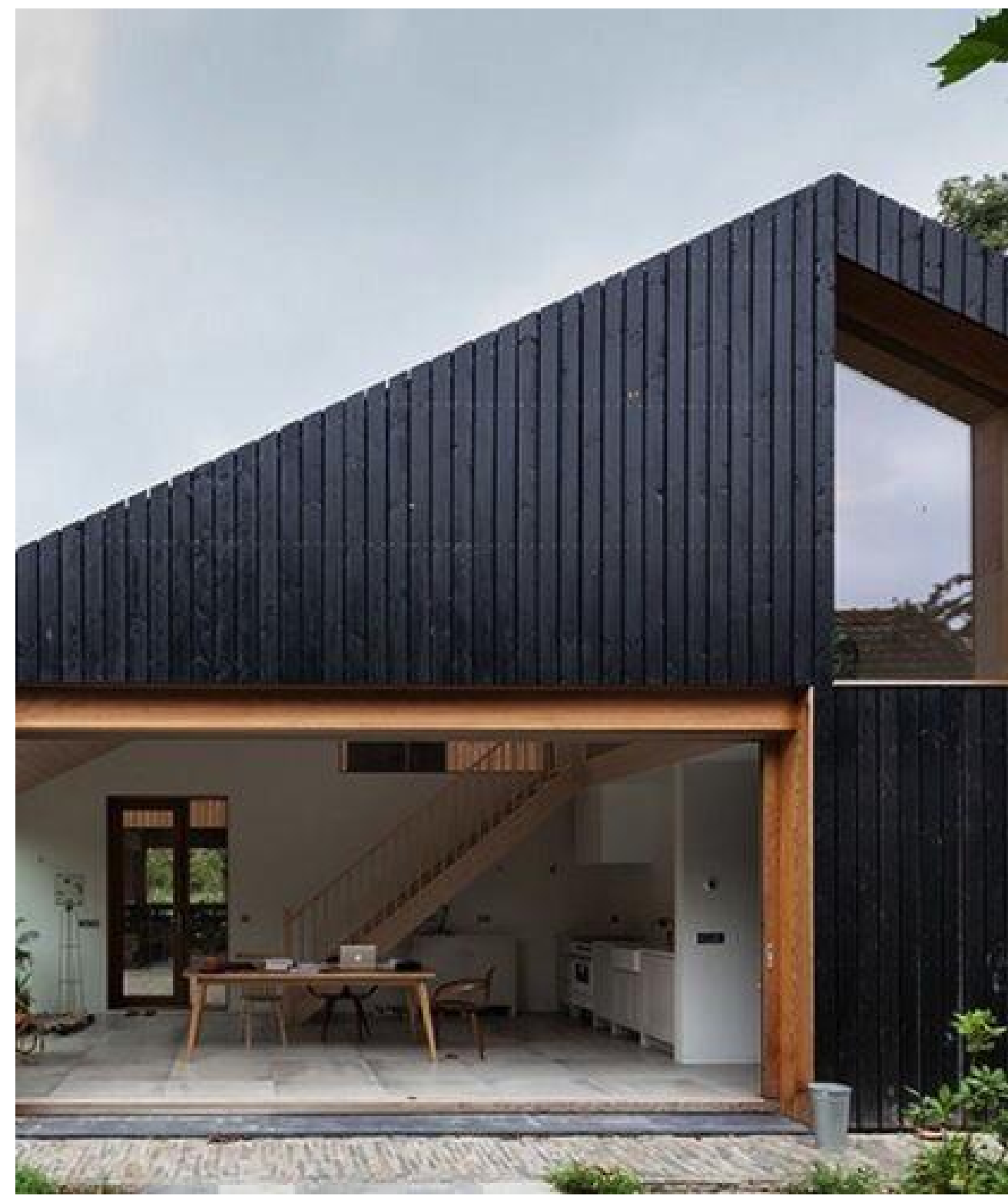
Verticale planken van zwart gebeitst hout als gevelbekleding
