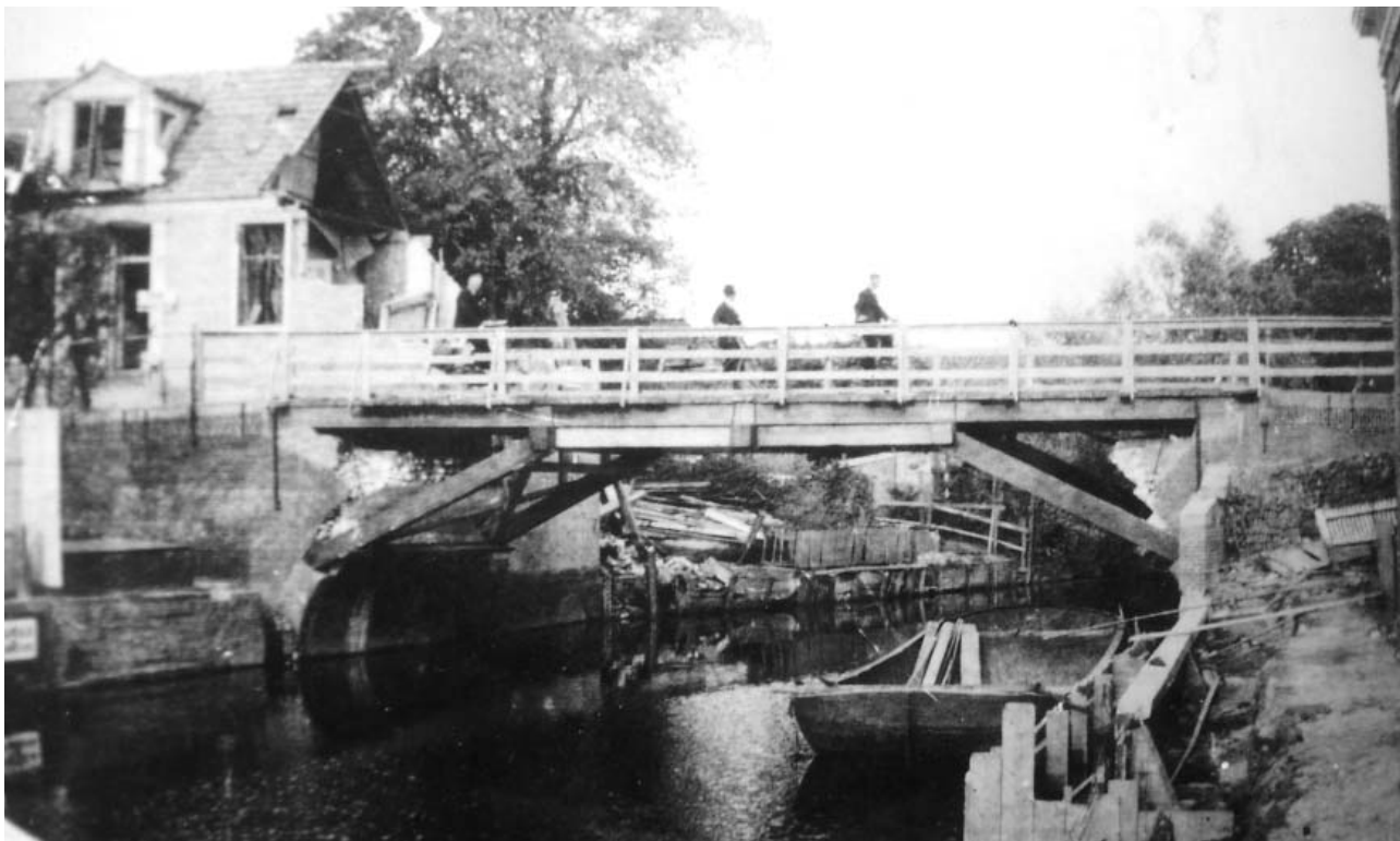
Het verwoeste pand met noodbrug
