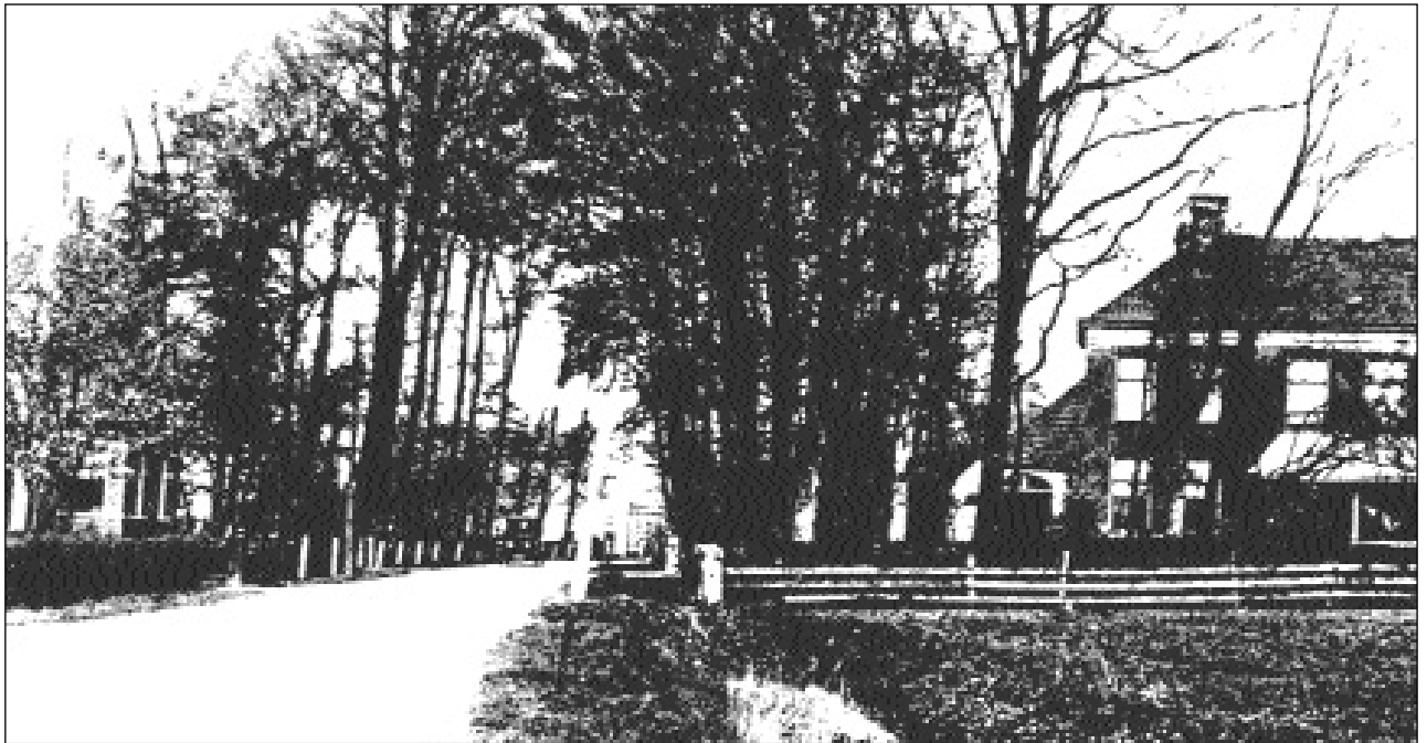
Het pand Bellingeweer 27 met verdieping, zoals het er voor de ingrijpende verbouw van 1939 uitzag (gezien vanuit het zuiden). Foto: P. Noord.
