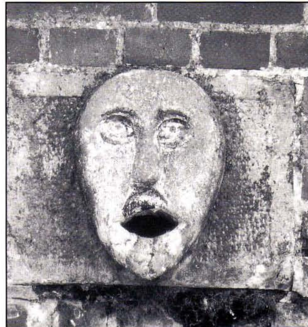
Fig.3 Waterspuwer aan oostzijde van de Schaphalsterzijl.
